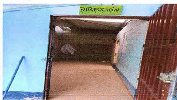
Foto 2: Colocación de piso cerámico en la dirección.
