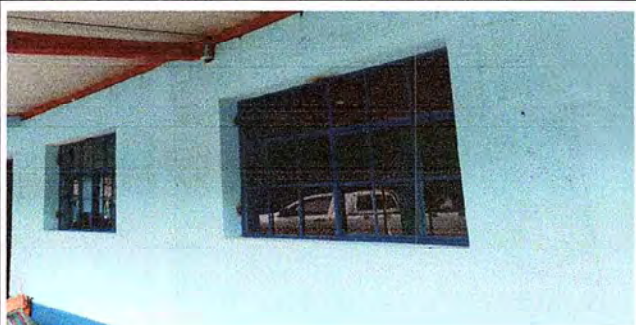
Foto 3: Colocación de ventana-balcón de las dos aulas.
